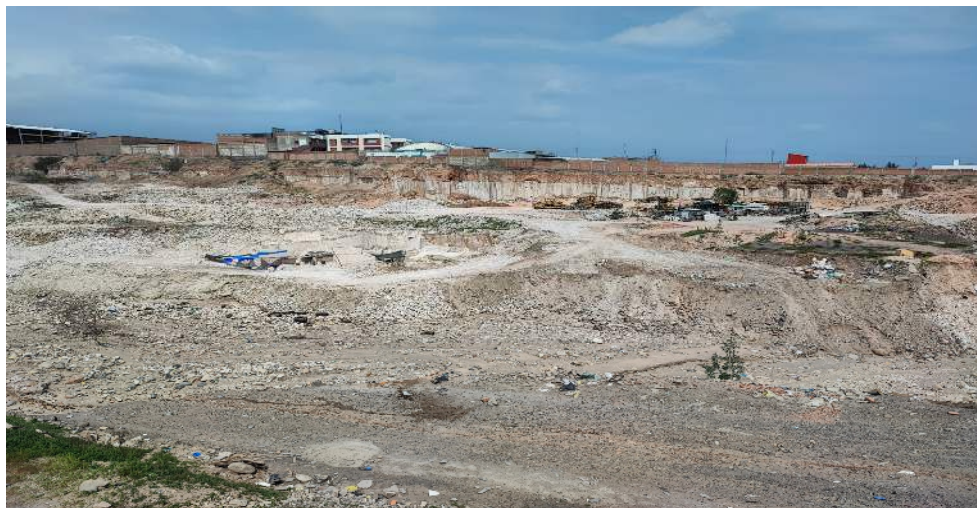
FIGURA N°02: SE OBSERVA TRAMO CRÍTICO COLMATADO Y CON MATERIAL DE SILLAR PRODUCTO DE EXPLOSIVOS
